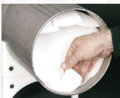
Insertar la presa en la tubería con el borde hacia la preparación de la soldadura.
