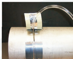
Insertar la varilla de gas de purga en la raiz.
