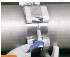
Ir retirando la cinta a medida que se avanza con la soldadura
